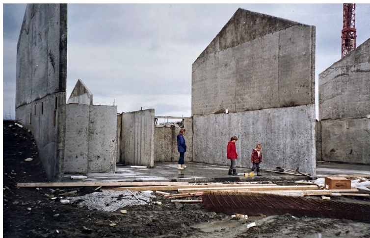
Rekkehus i Arne Fjellbus veg, øvre, under oppføring. Foto: Per Wist
