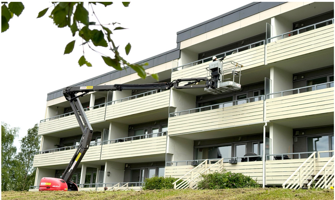
Vaktmesterassistent Sander er godt i gang med å vaske og skrape balkongene.
